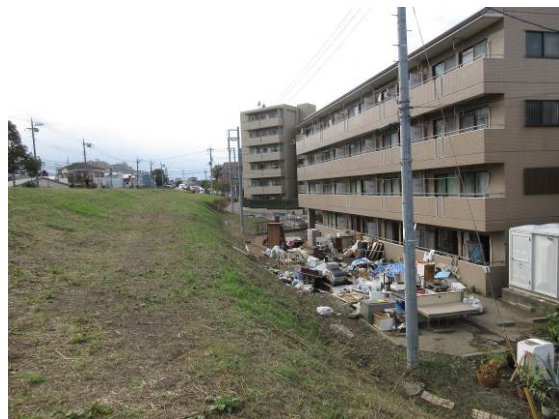
写真6 1階浸水で人的被害を生じた集合住宅（当社撮影）
