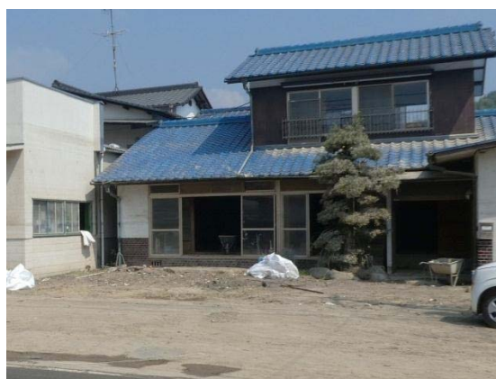
左：倒壊家屋、右：2階床高さの浸水を観測（弊社撮影）
